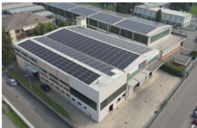
Nel 2024 OTIMsrl diventa green con un impianto fotovoltaico da 211 Kwp capace di coprire il 50% del nostro fabbisogno energetico annuo
