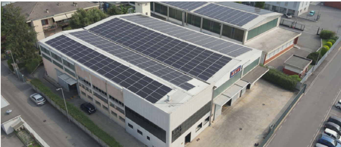
Nel 2024 OTIM srl diventa green con un impianto fotovoltaico da 211 Kwp capace di coprire il 50% del nostro fabbisogno energetico annuo
